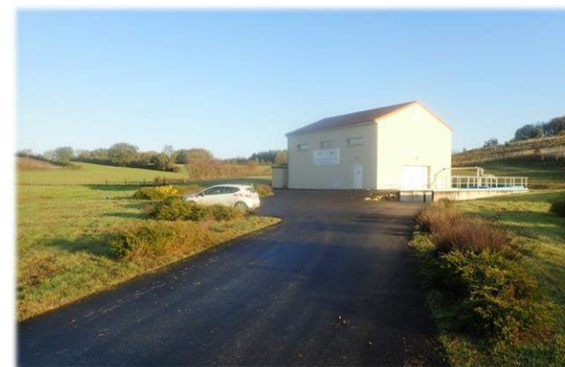
J4.2 – Réseaux routiers
