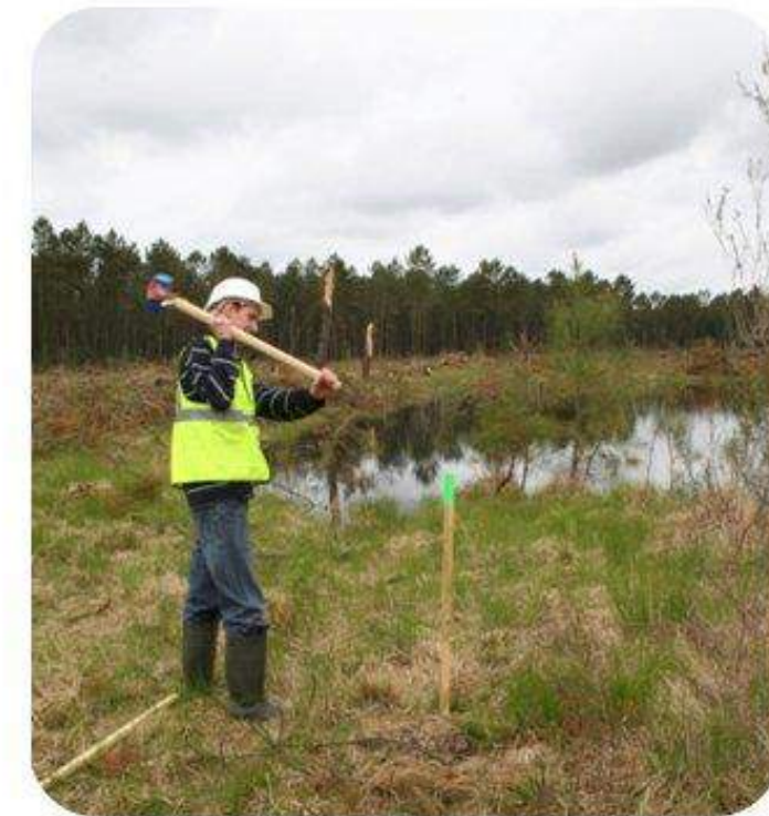
Photo 46 : Balisage et limitation de l'emprise du chantier sur les zones humides
