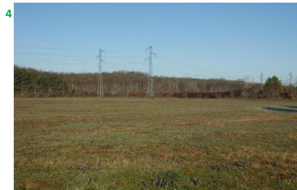
Lignes haute tension sur le site
